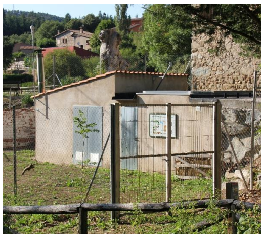
Dipòsit de subministrament de gas Font: Elaboració pròpia
