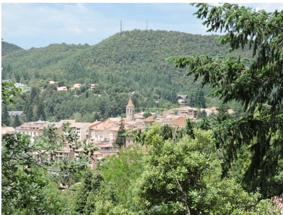
Fotografia 1. Vista de Viladrau des del sud-est. En primer terme part antiga i al fons serres del nord de la zona estudiada.
