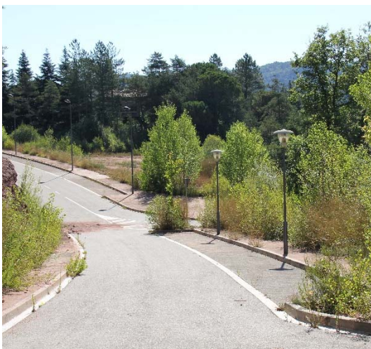
Urbanització de "Les Guilleries". Sòl urbanitzable
