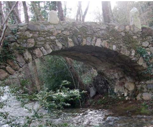
Element d'obra civil en el SNU
