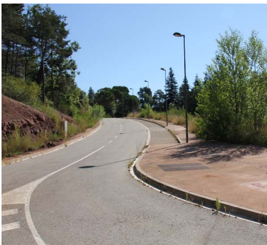
Urbanització de “Les Guilleries”. Sòl urbanitzable
