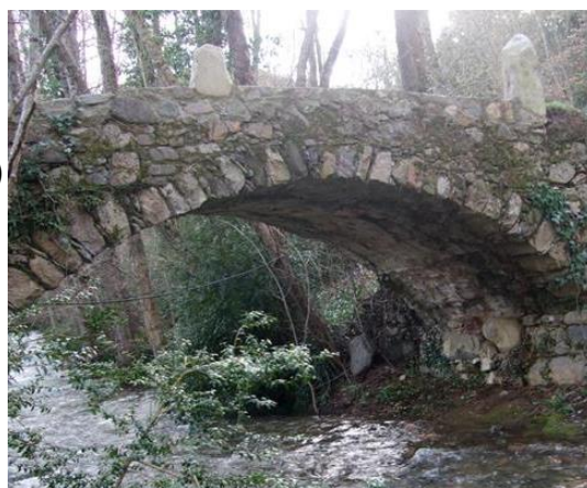
Element d'obra civil en el SNU
