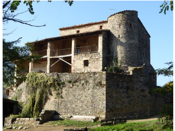
Element de patrimoni arquitectònic en el SNU. Font: Elaboració pròpia
